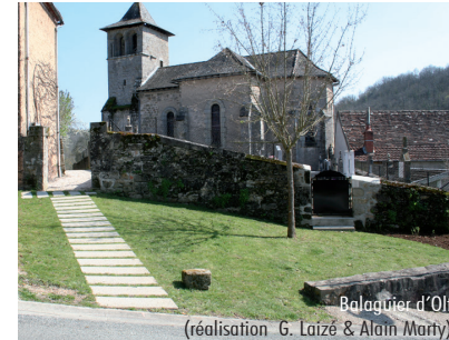
Chemin en dalles bétons à joints enherbés (Balaguier d'Olt 12)
