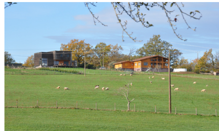
Maisons sur le Ségala : avec son bardage en bois foncé, la maison de gauche s'intègre mieux dans son environnement que celle de droite, au bois trop « jaune » et à l'architecture de chalet montagnard
