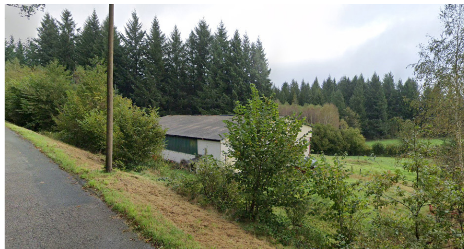
A Sousceyrac-en-Quercy, la végétation permet de rendre discret un bâtiment qui aurait été trop visible.
