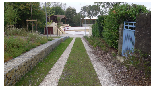
Image de référence : aménagement d'un chemin de roue en béton en lieu et place d'une voie d'accès toute largeur en béton (Donzac 40).
