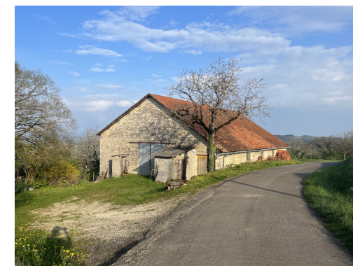
Grange en pierre, d'architecture traditionnelle, dominant la vallée de la Tourmente en limite Est du causse de Martel
