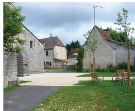
Placette carrossable traitée en sable calcaire compacté (Issendolus)
