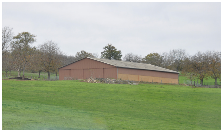
Bâtiment en tôle ondulée marron, avec un volume simple et bas. Il est également placé dans un coin de la parcelle ce qui facilite son intégration.
