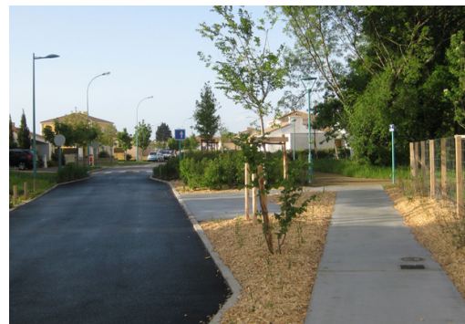
Exemple de continuités piétonnes et trottoirs simples mais qualitatifs, aménagés le long des voies de desserte d'un lotissement - Pont-Saint-Martin (44) - Le Haugard 3
