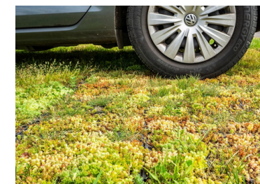
Mélange de sedums et couvres sols sur dalles alvéolaires
