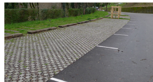
Exemple de dalles alvéolaires en béton remplies de gravier
