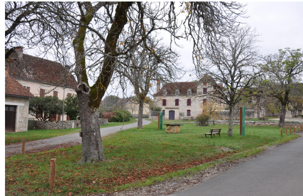
Une partie du couderc de Blanat à Rocamadour : l'herbe et les arbres apportent une qualité simple et efficace à l'espace public. Un cheminement calcaire vient compléter le tout, seule la route est revêtue de bitume.
