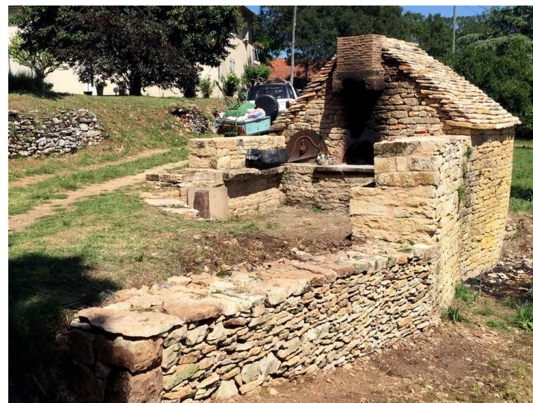
Four banal de Palmayssou (Cressensac-Sarrazac) qui a fait l'objet de chantiers participatifs durant 4 ans pour sa restauration
