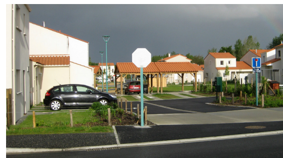
Exemple de voie en impasse dans un lotissement, comprenant une aire de manœuvre pour les secours, mais traitée comme une courrée - Pont-Saint-Martin (44) - Le Haugard 3
