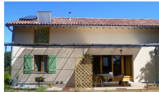
Maison bioclimatique à large débord de toit + pergola côté sud + ossature bois, remplissage paille, enduit terre à Lacapelle-Cabanac (46) - autoconstruction
