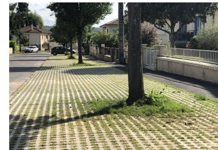
Dés-imperméabilisation d'une bande de stationnement en bord de voirie avec dalles alvéolaires béton enherbées (Prayssac 46)
